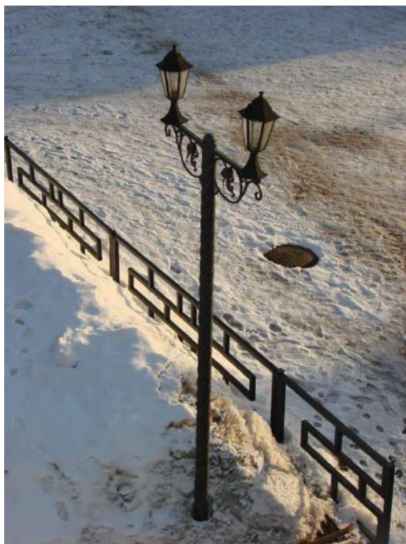
Вариант 1: Описание: столб из витой трубы Ø89мм, длина – 3,8м
